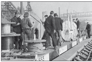
De aanleg van transportbanden bij de Buitenkade van Hoogovens.
