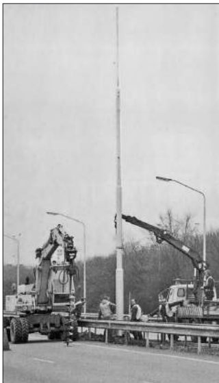
Lijnverlichting is een specialisme van Van Vuuren Elektrotechniek. Deze foto's laten zien hoe in opdracht van Rijkswaterstaat de lijnverlichting langs de A9 werd aangebracht. Eerst aan de noordzijde van de Velsertunnel; later tot aan Uitgeest. In de jaren na 1986 zijn meerdere wegdelen van het Noord-Hollands Rijkswaterstaat-wegennet voorzien van dit soort verlichting. Eén van de bekendste wegdelen is het gedeelte tussen Uitgeest en Alkmaar. Die bekendheid kwam doordat het programma Over de Balk hier aandacht aan besteedde omdat de geplaatste verlichting niet aan mocht vanwege een beschermde uilenkolonie ter hoogte van Akersloot.
